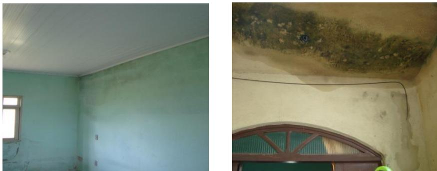
Figura 3. Casas 01 e 02 com problemas de infiltração e umidade.
